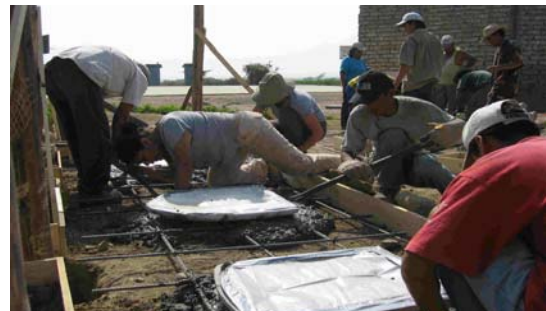
Pouring concrete around the pour-flush toilet bowls
